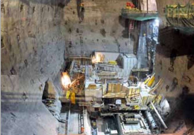
Baustelle Limberg II
